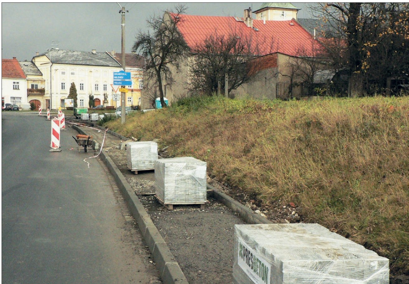
Budování chodníku k rondelu U Jakuba
