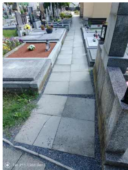
Byly provedeny opravy několika chodníků, které byly v havarijním stavu
